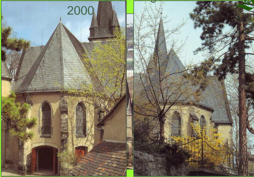
Kath. Pfarramt Jena, Sanierung der Pfarrkirche -St. Johann Baptist-
