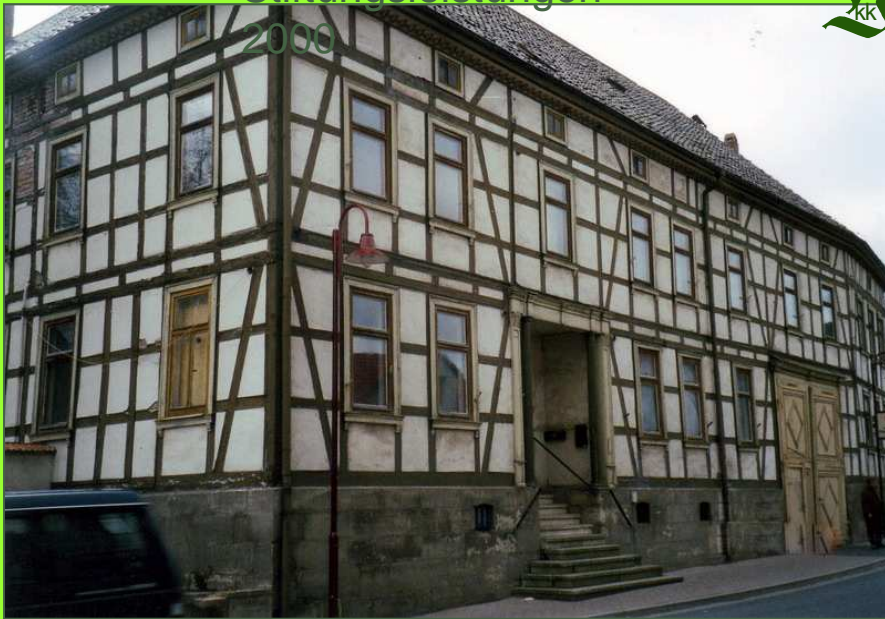
Kath. Pfarramt Küllstedt, Sanierung Kindertagesstätte
