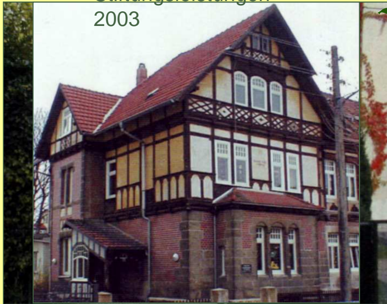
Ev. Kirchenkreis Mühlhausen, Aufbau evang. Schulzentrum
