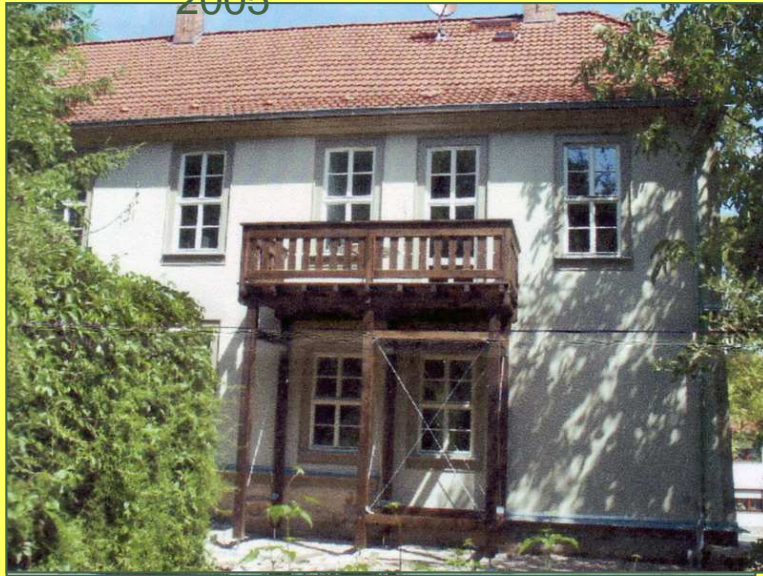
Ev. Kirchengemeinde Bad Tennstedt, Sanierung Gemeinderaum Pfarr
