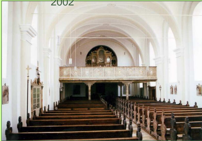
Kath. Pfarrgemeinde Steinbach, Innensanierung der Kirche
