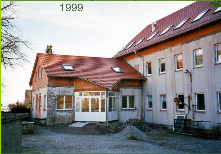
Kath. Kindergarten Worbis, Sanierung Eingangsbereich
