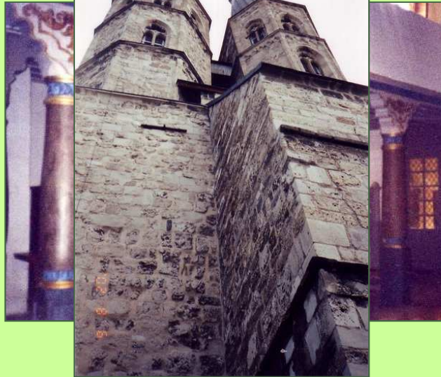
Ev. Kirchgemeinde Nordhausen, Sicherungsarbeiten an der Blasiikirche
