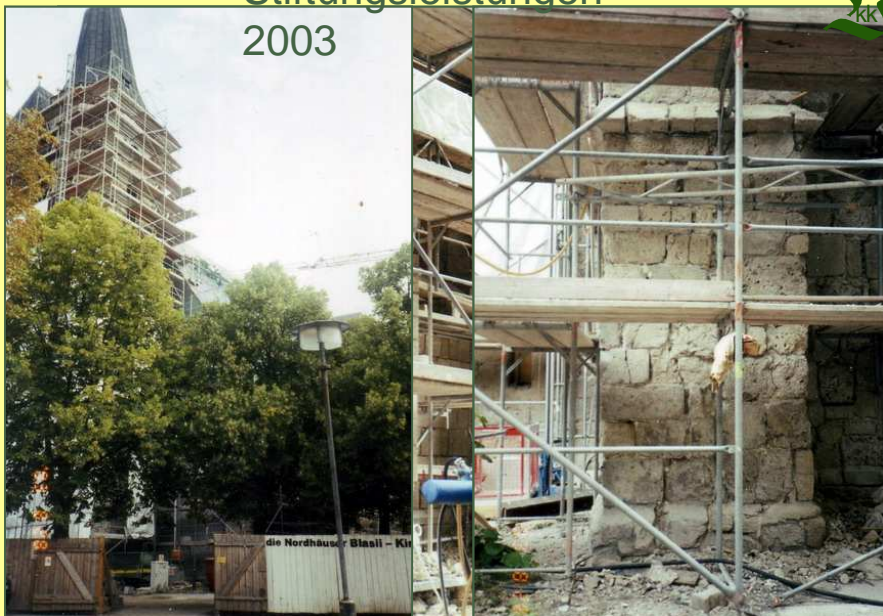
Ev. Kirchengemeinde Nordhausen, Instandsetzung der Blasii-Kirche
