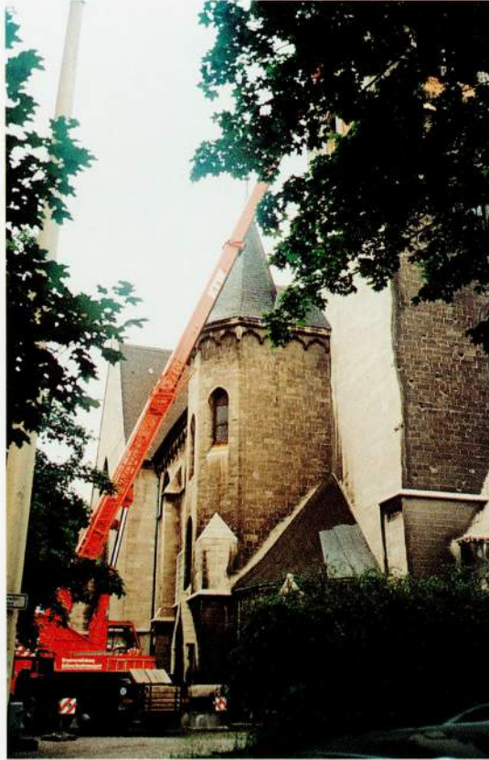
Sanierungsarbeiten am Turm der Thomaskirche in Erfurt
