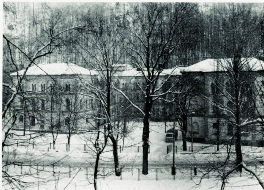
Fachkrankenhaus Ilfeld, ehemalige Klosterschule des Ilfelder Stifts
